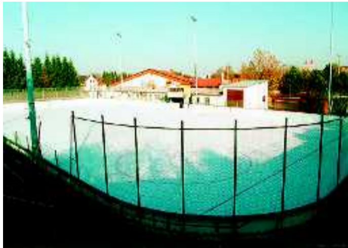
Das Moosburger Eisstadion ist schon jahrelang in einem wirklich schlechten Zustand. Fotos: Griebner
